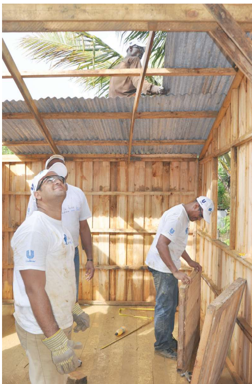
Construyendo viviendas con un Techo para mi país .
